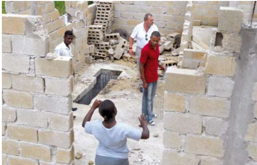
In Haiti unterstützt der Samariterbund unter anderem den Aufbau einer Ambulanz in St. Étienne (Léogâne), deren Rohbau durch das Erdbeben beschädigt wurde.
